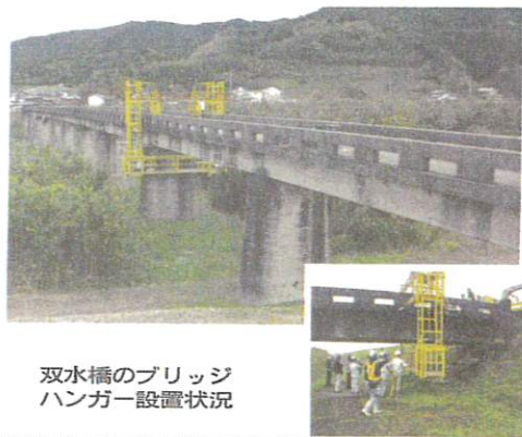
鈴久名橋のブリッジハンガー設置状況
